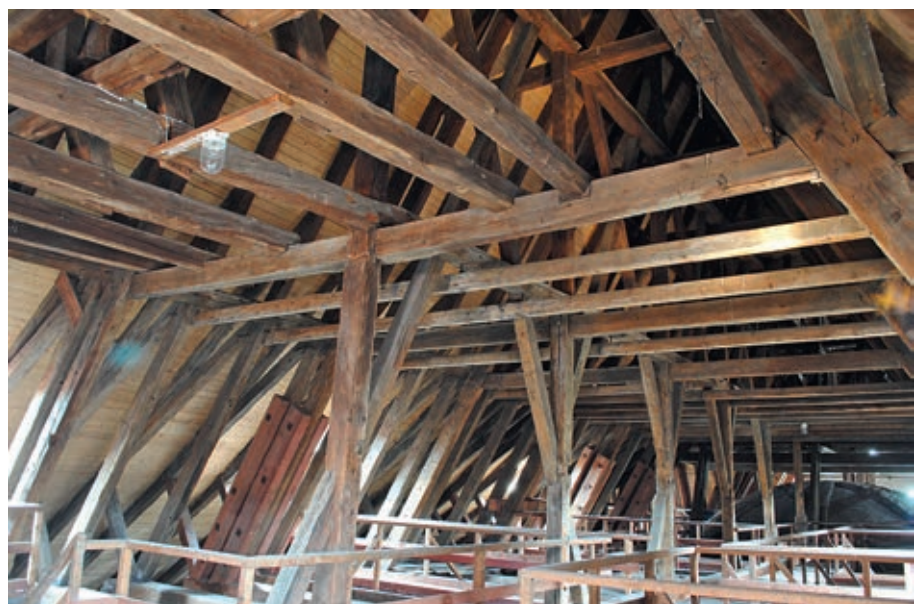
Passau, St. Nikola, Dachraum über dem Kirchenschiff nach Nordosten; im Vordergrund der Längsverband unter dem First (Foto: BLfD, Karl Schnieringer)
