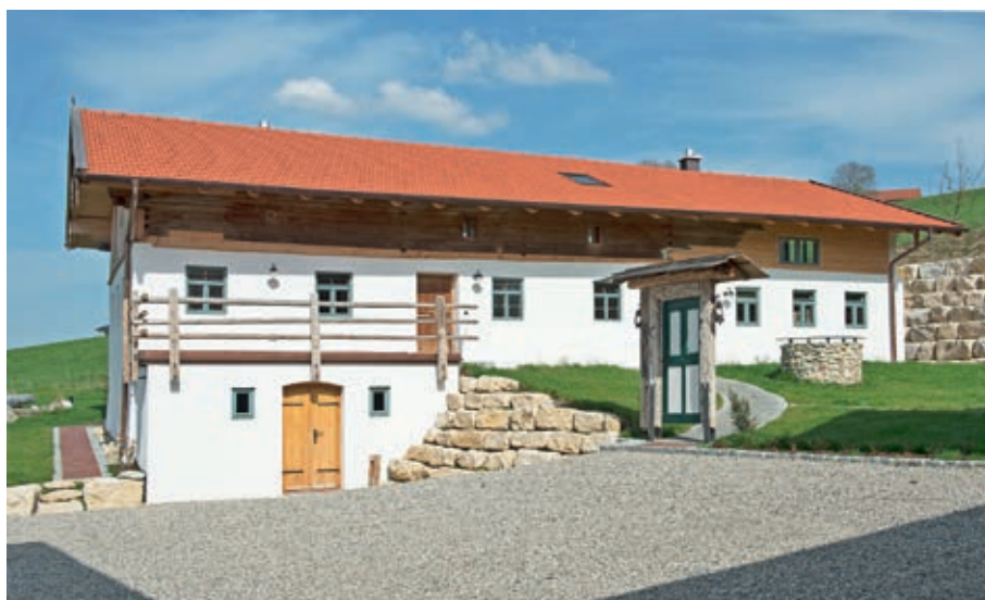
Sankt Wolfgang-Zwickl, Lkr. Erding, instandgesetztes Wohnstallhaus, im Kern aus dem 16. Jh. (Foto: BLfD, Michael Forstner)
