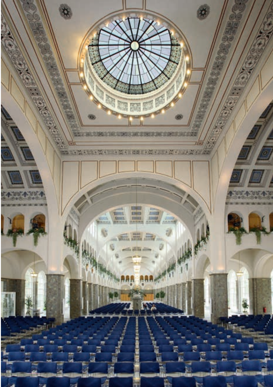
Bad Kissingen, Wandelhalle (1910–12). Ein frühes Beispiel für die Verwendung von Stahlbeton in der repräsentativen Architektur (Foto: Stadtarchiv Bad Kissingen, Feuerpfeil GmbH)
