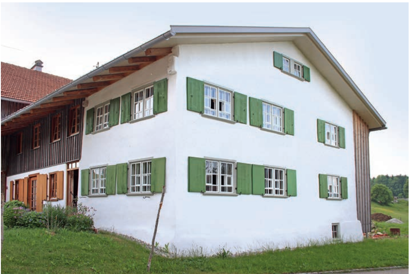
Gablers 181, jetzt wieder bewohnbar: das Bauernhaus nach der Instandsetzung (Foto: BLfD, Michael Habres)
