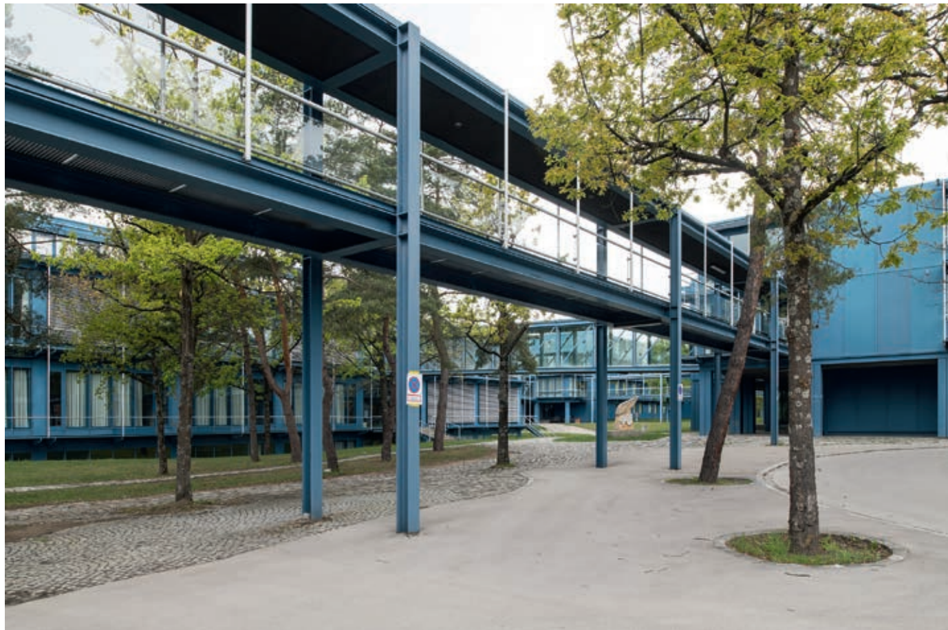
Fürstenfeldbruck, Offizierschule. Verglaste Stahlfachwerkbrücken, Kunst im Außenbereich (Fotos: Michael Forstner, BLfD)
