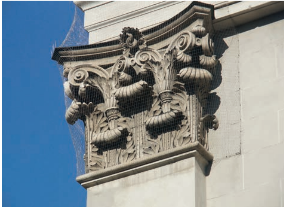
Professionell verlegtes Taubennetz und -stifte zur selektiven Absperrung von Bauornamenten (Foto: Martin Mach)
