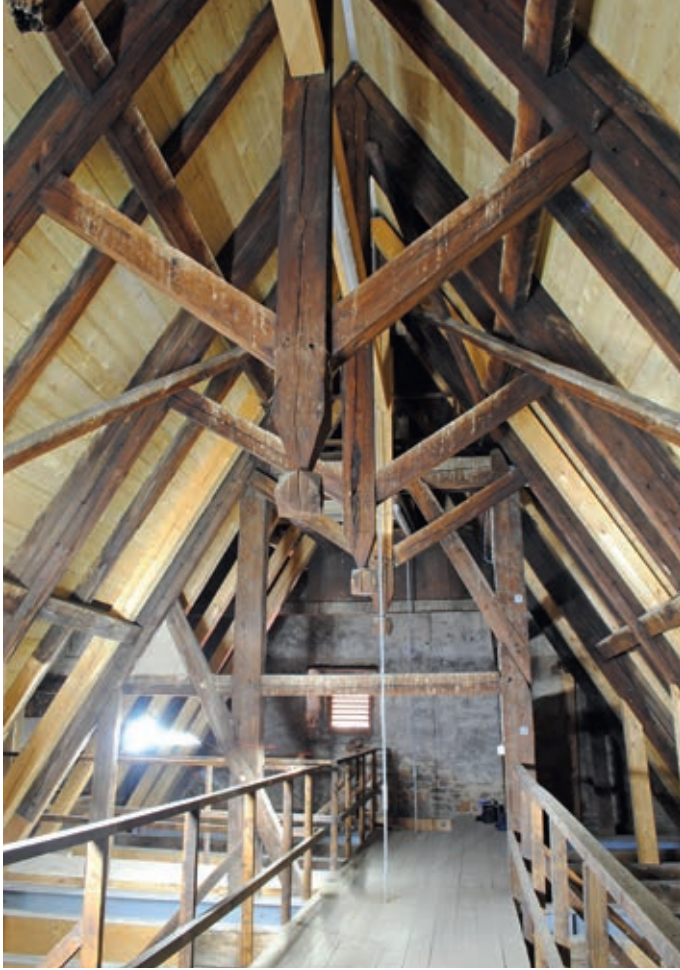
Amberg, St. Leonhard, Dachraum nach Westen (Foto: BLfD, Karl Schnieringer)
