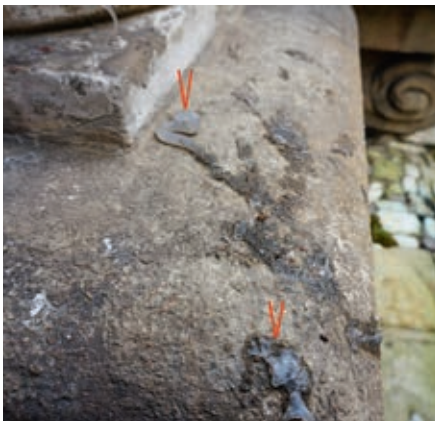
Wenn Taubenpaste, wie hier im Bild, auf die eigentlich zu schützenden Oberflächen abstürzt, verfehlt sie ihren Zweck (Foto: Martin Mach)
