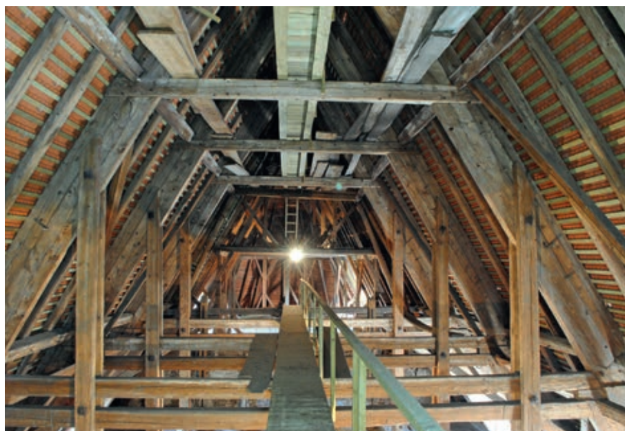
Passau, St. Severin, Dachraum, obere Ebene nach Osten (Foto: BLfD, Karl Schnieringer)
