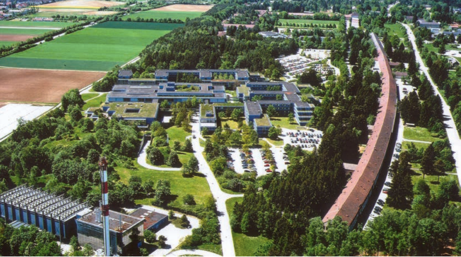
Fürstenfeldbruck, Offizierschule, Heizkraftwerk und Kasernenanlage, Luftbild, 1970er Jahre (Luftbild: Bundeswehr, Fürstenfeldbruck)
