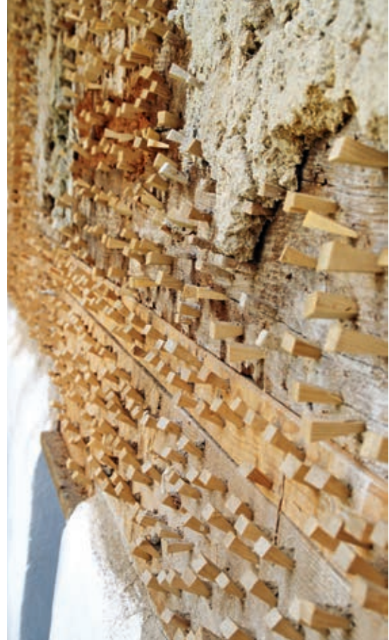
Gablers 181, das Balkenwerk der Fassade wird zur besseren Putzhaftung mit Hartholzkeilen, sog. Bissen, gespickt (Foto: Franz Vogler, Oberstdorf)
