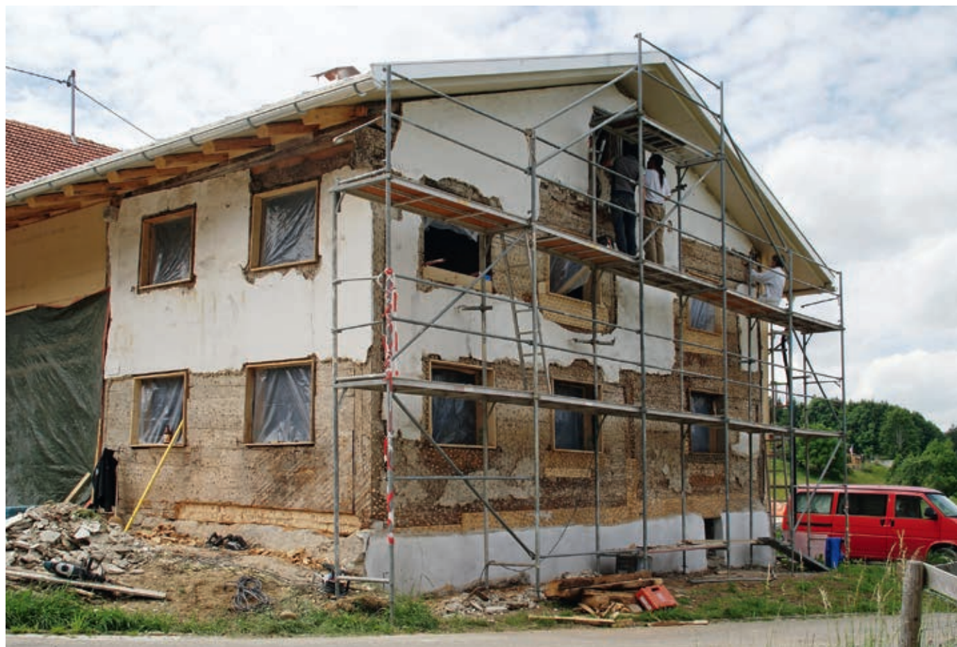
Gablers 181, Wohnteil während der Fassadeninstandsetzung mit teilweise erhaltenem Putz (Foto: Franz Vogler, Oberstdorf)
