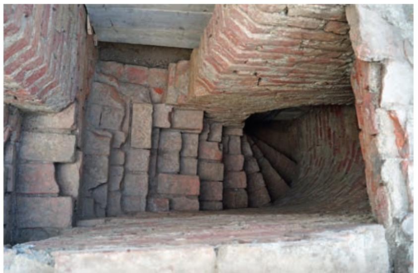
Augsburg. Treppenabgang (c) zur Kasematte mit Eingang zum Ober- und Untergeschoss (Foto: Günther Fleps)
