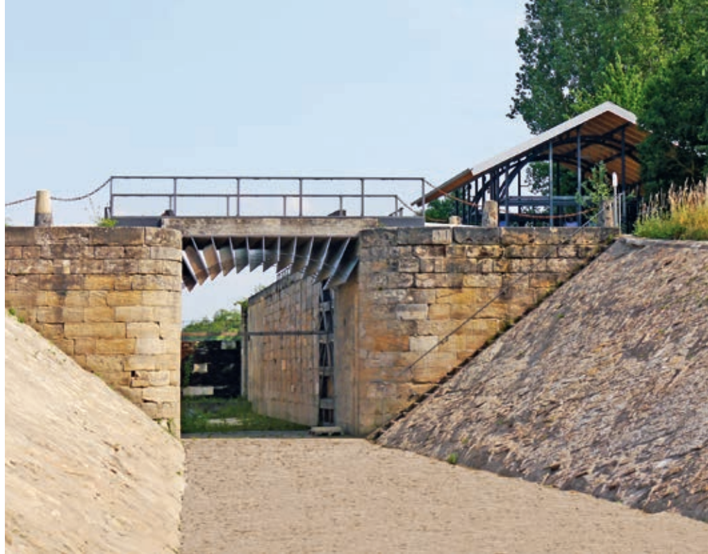
Eggolsheim-Neuses, Lkr. Forchheim, instandgesetzte Schleuse 94 des im 19. Jh. entstandenen Ludwig-Donau-Main-Kanals (Foto: Reiner Schütz)
