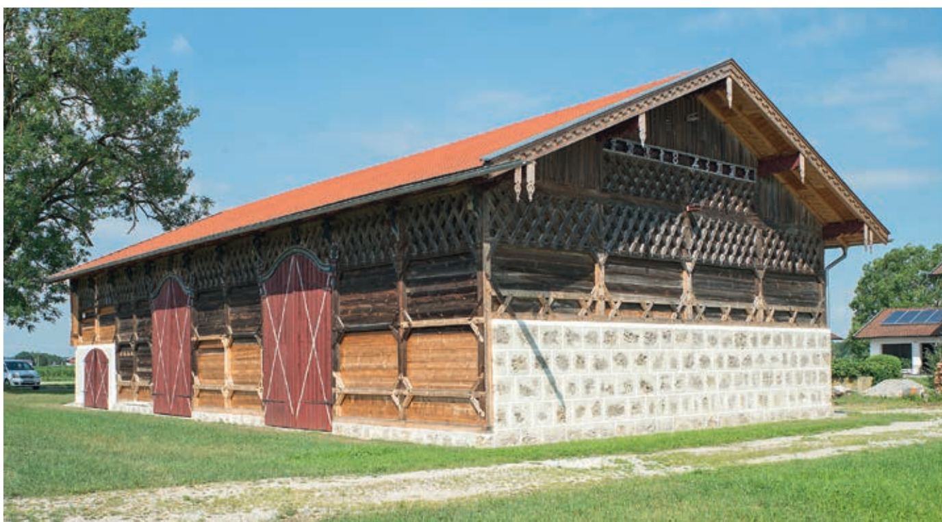
Denkmalschutzmedaille 2019: Garching a. d. Alz, Lkr. Altötting, instandgesetzter Bundwerkstadel von 1845 (Foto: BLfD, Michael Forstner) – siehe S. 92 ff.
