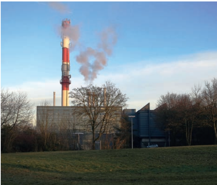
Fürstenfeldbruck, Offizierschule, Heizzentrale (Foto: Detlef Knipping, BLfD)
