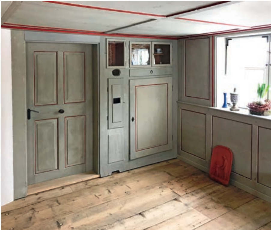
Gablers 181, untere Stube nach der Instandsetzung (Foto: Armin Waibel, Gablers)
